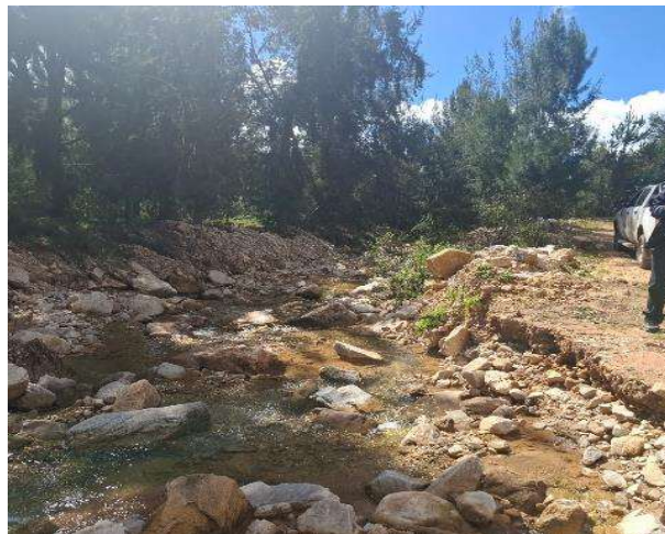
IMAGEN 02: SE MUESTRA LA EROSION EN LA MARGEN DERECHA DE LA QUEBRADA SARINMAYO Y ASI LA SOCAVACION DE LA TROCHA CARROZABLE REQUIRIENDO MANTENIMIENTO DEL CAUCE DE LA QUEBRADA
